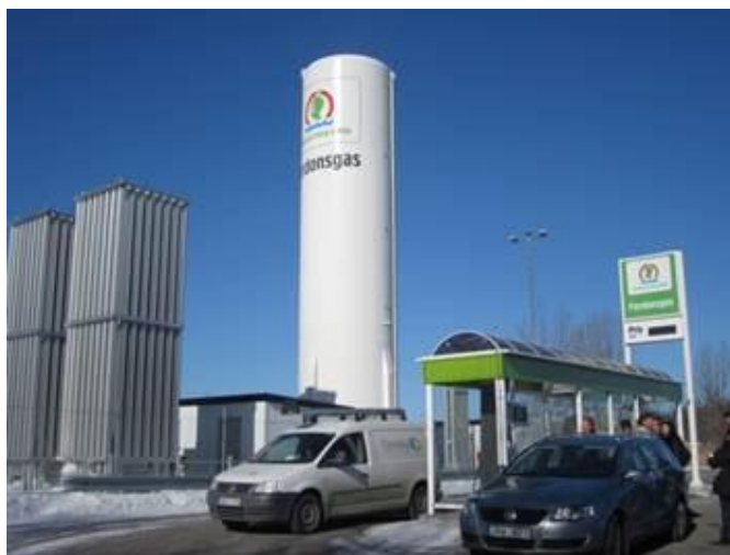
Kuva 15. Esimerkki biometaanin jakeluasemasta, kaasuvarasto maan pinnalla pystyasennossa.
