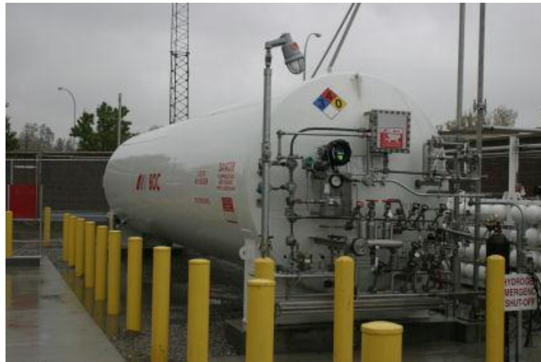
Kuva 19 Vedyn maanpäällinen varastosäiliö [35]
